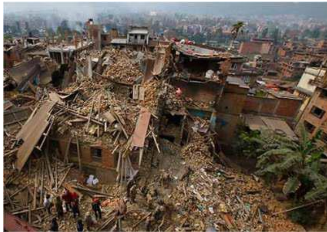
Figure 2 നേപ്പാൾ ഭൂചലനം, ഏപ്രിൽ 2015 സ്രോതസ്: Training of Masons on Hazard-Resistant Construction, NDMA
