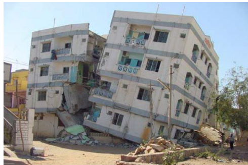
Figure 62 തുറസ്സായ ഗ്രൗണ്ട് ഫ്ലോറിലെ ആർ.സി.സി തൂണുകൾ തകർന്നതുമൂലം നിലംപതിച്ച കെട്ടിടം, 2001 ഭൂജ് ഭൂചലനം. സ്രോതസ്: Earthquake Tips: Learning Earthquake Design and Construction, IITK-BMTPC
