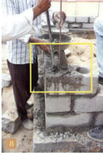
Figure 107 കോൺക്രീറ്റ് കട്ടകൾ കൊണ്ടുള്ള ചുമരുകളിലെ ലംബ ബന്ധനങ്ങൾ സ്രോതസ്: Manual on Hazard Resistant Construction in India: For Reducing Vulnerability in Buildings Built Without Engineers and Earthquake Safe Construction Of Masonry Buildings Simplified Guideline For All New Buildings In The Seismic Zone III Of India
